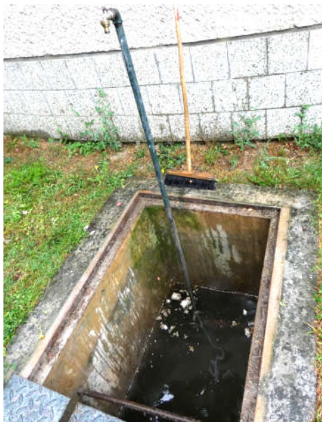
zaplavená šachta pri bočnom vchode do kostola (110 cm vody)
