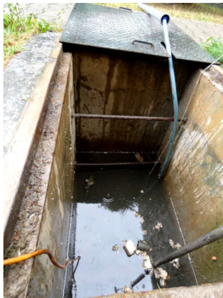
zaplavená šachta pri bočnom vchode do kostola (110 cm vody)
